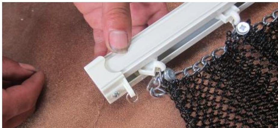
将轨道封闭件安装在轨道的两侧。
