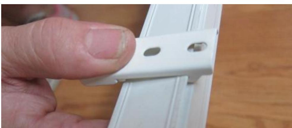
将吊码另一端直接压入轨道
