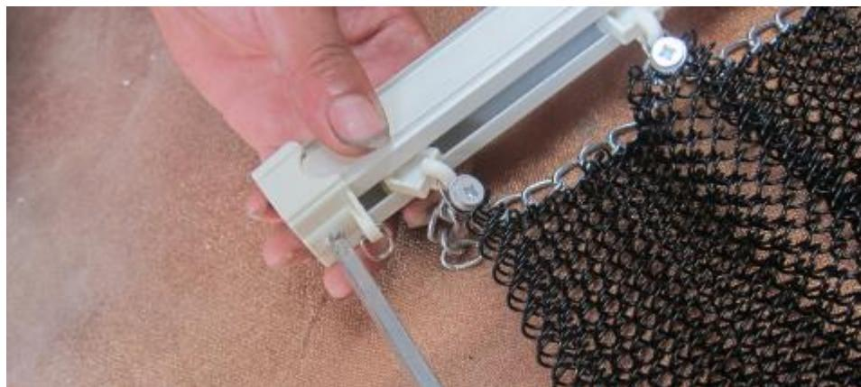
旋紧轨道封闭件上的螺丝，将其固定。
