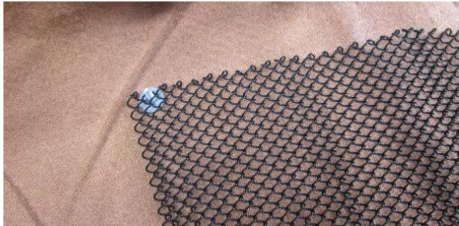
从网的一侧开始安装，首先将固定螺丝穿过网孔。
